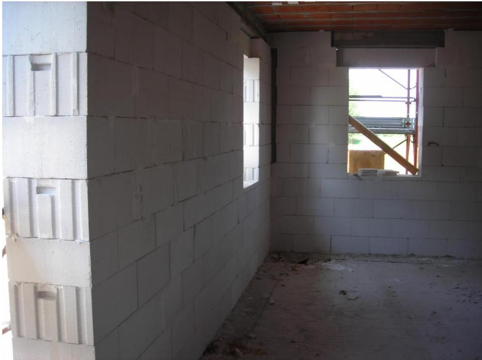
I pilastri in c.a., nella facciata esterna ed interna , sono stati rivestiti con tavelle dello stesso materiale di tamponamento YTONG di spessore idoneo.
